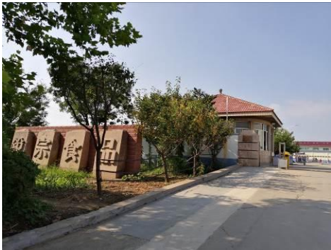
图 2-5 110kV 莱梅线 54#-55#/110kV 莱南线 62#-63#线东 1m 青岛锐宗食品有限公司
