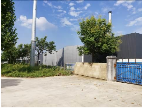
图 2-3 110kV 莱梅线 53#-54#/110kV 莱南线 61#-62#线东 1m 厂房
