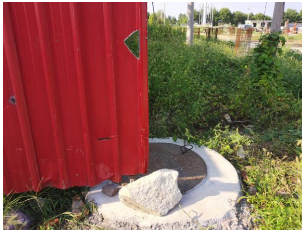
图6-3 电缆沟周围土地恢复
