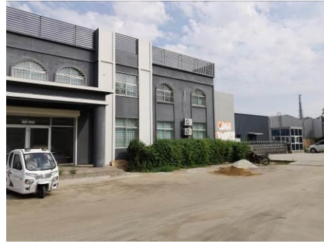
图 2-4 110kV 莱梅线 53#-54#/110kV 莱南线 61#-62#线东 5.4m 厂区办公楼
