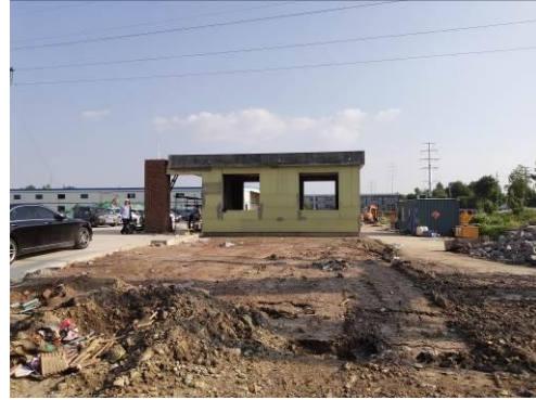
图 2-8 110kV 莱梅线 59#-60#/110kV 莱南线 67#-68#线南 6.2m 在建看护房
