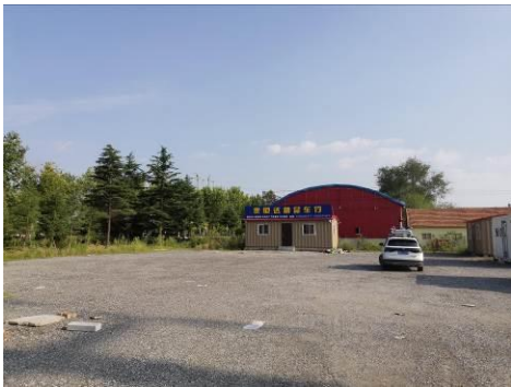
图 2-9 110kV 莱梅线 61#-62#/110kV 莱南线 69#-70#线南 29m 车场看护房
