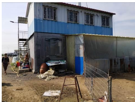
图 2-15 110kV 莱梅线 106#-107#/110kV 莱南线 114#-115#线南 28m 养殖看护房
