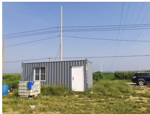
图 2-14 110kV 莱梅线 96#-97#/110kV 莱南线 104#-105#线西 5.1m 果园看护房
