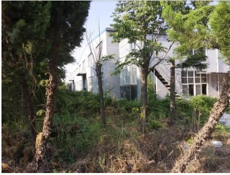
图 2-7 110kV 莱梅线 56#-58#/110kV 莱南线 64#-66#线东 1m 莱西鑫杰木业
