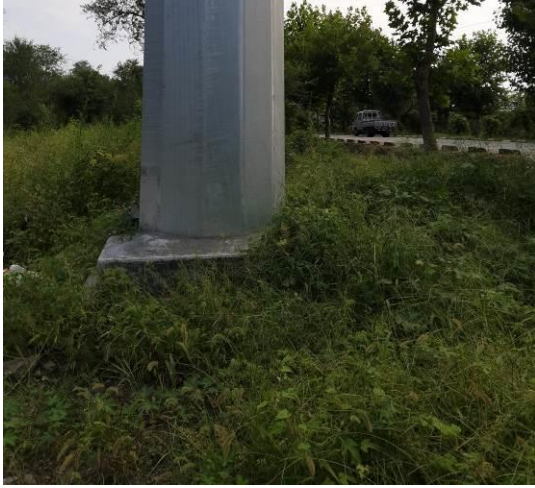
图6-1 110kV 莱梅线51#/110kV 莱南线59#塔基周围土地恢复
