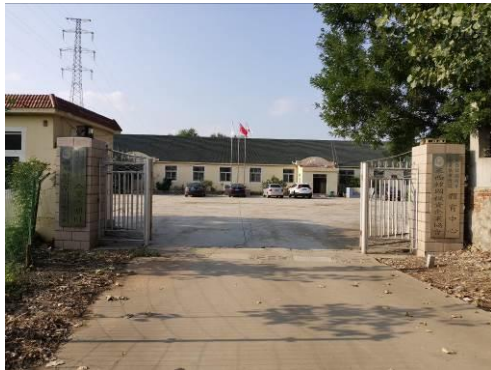
图 2-11 110kV 莱梅线 62#-63#/110kV 莱南线 70#-71#线东 14.5m 韩国投资企业协会
