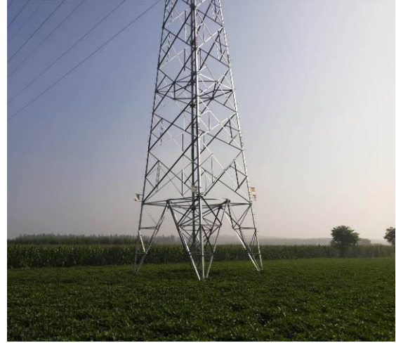
图6-2 110kV 莱梅线86#/110kV 莱南线94#塔基周围土地恢复
