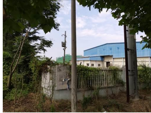
图 2-2 110kV 莱梅线 52#-53#/110kV 莱南线 60#-61#线东 1m 九联蔬菜加工厂
