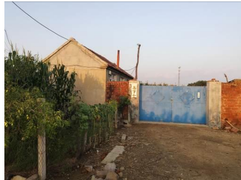
图 2-12 110kV 莱梅线 76#-77#/110kV 莱南线 84#-85#线东 17.5m 民房
