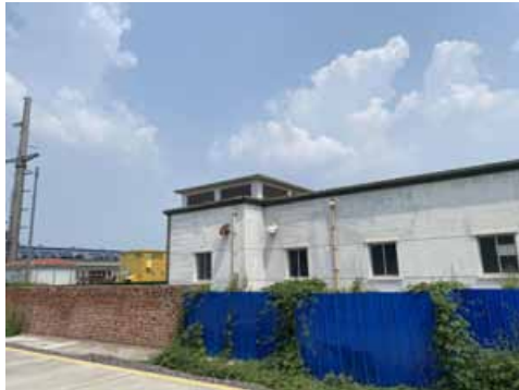
图 4-3 汇泉 110kV 变电站东侧
