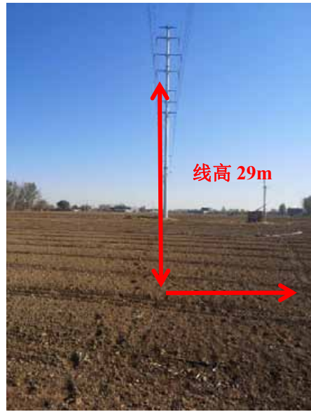
图 7-2 110kV 汇泉 T 线/110kV 锦汇线 26#-27#, 向南衰减
