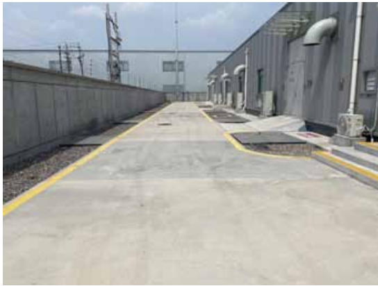
图6-3 变电站内路面硬化
