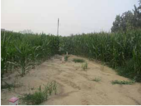
图6-7 电缆沟周围恢复
