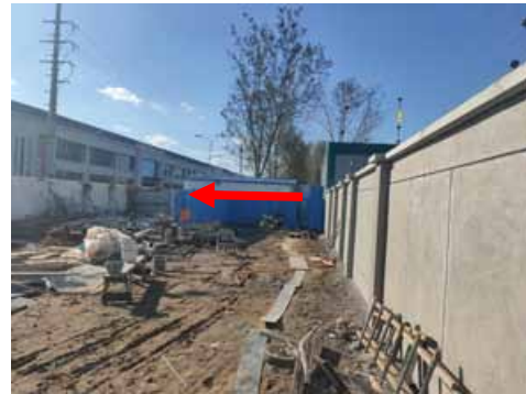
图 4-4 汇泉 110kV 变电站南侧
